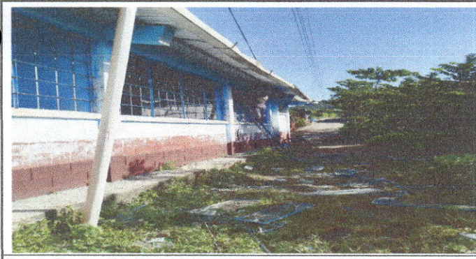
Foto 5: Sustitución de canal de metal Y Sustitución de bajada de agua pluvial de metal por tubo PVC 3"
