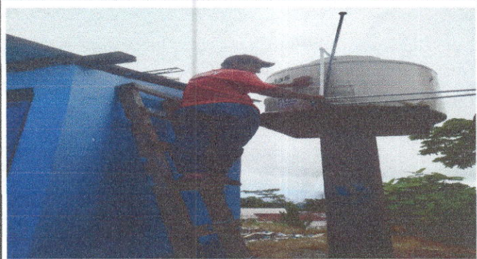
Foto 4: Sustitución de deposito de agua 1100 lt
