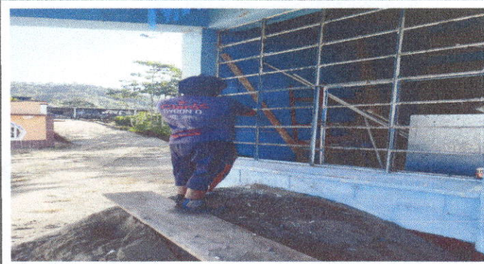
Foto 3: Mantenimiento de estructura de metal ventanas, modulo de aula.
