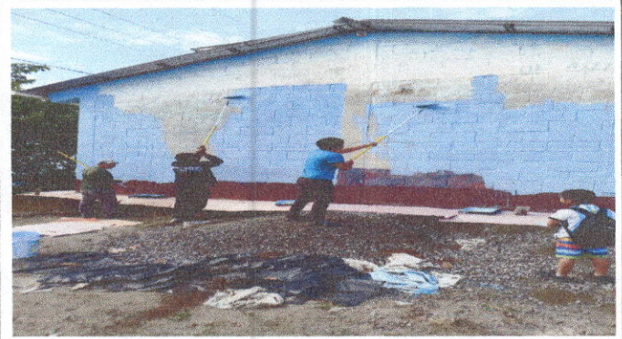
Foto 2: Pintura en muros exteriores e interiores, modulo de aula.
